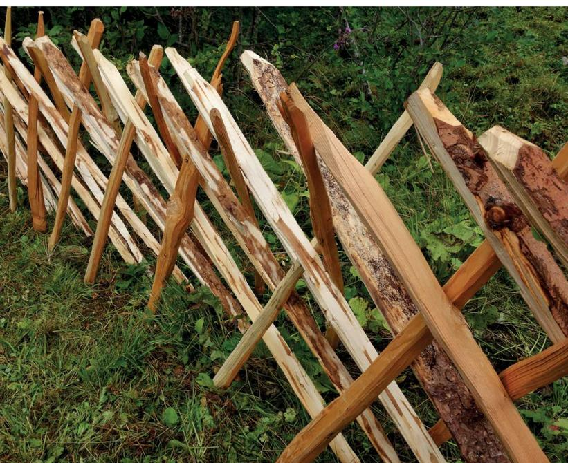
Foto links: Hier sieht man die Bauweise eines Schrägezauns aus der Nähe.
